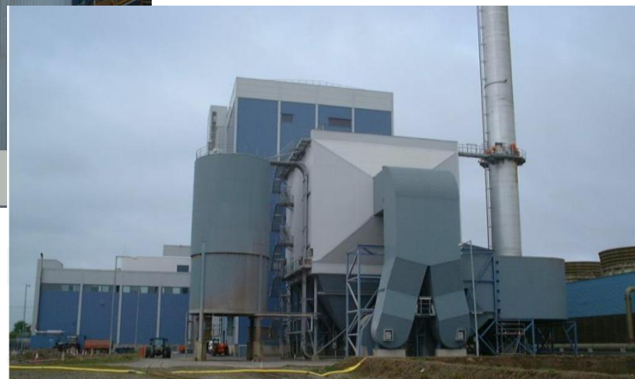
Установка электрофильтра ФИНГО в Ирландии
