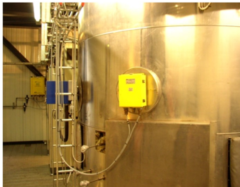
Подключение расходомера
