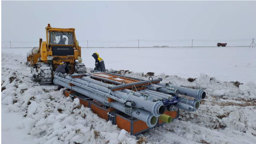
Перевозка пакетов с опорами по тундре волоком
