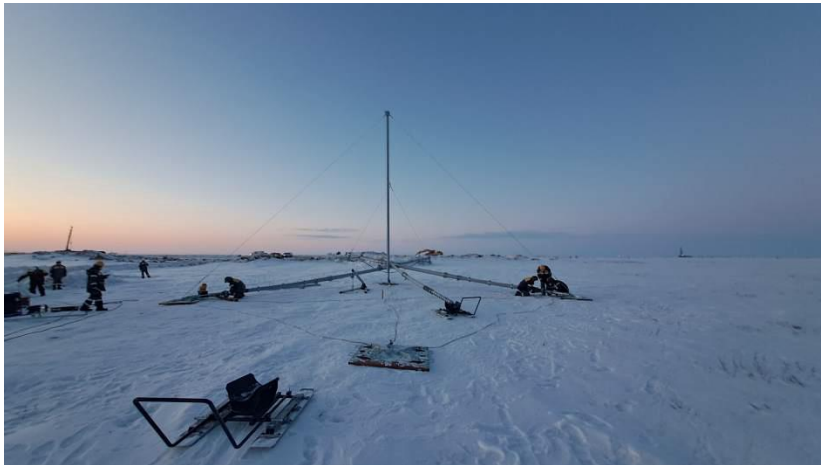
Ручные приспособления для сборки и возведения опоры
