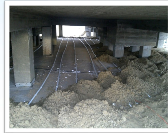
Система трубопроводов для охлаждения грунта
