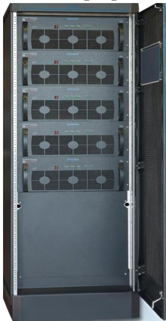
Стойка ЭВУ с пятью модулями
