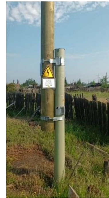
Композитный свайный фундамент ПАО «Якутскэнерго»
