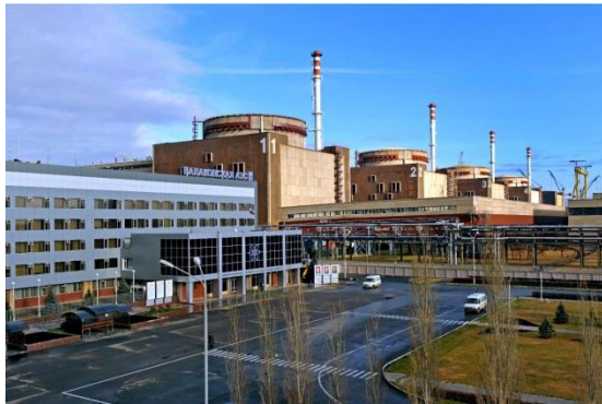
Балаковская АЭС г. Балаково
