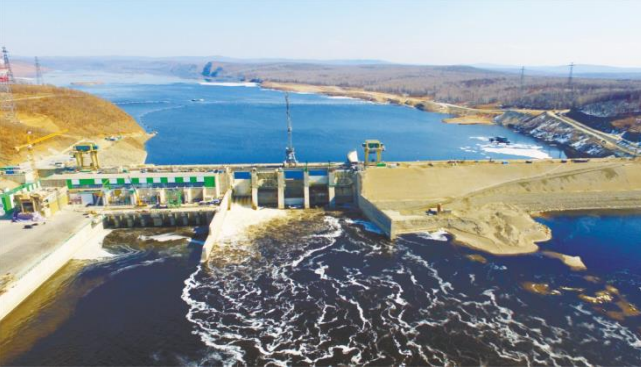
Нижне-Бурейская ГЭС, пгт. Новобурейский
