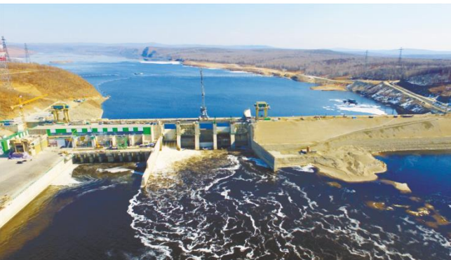
Нижне-Бурейская ГЭС, пгт. Новобурейский
