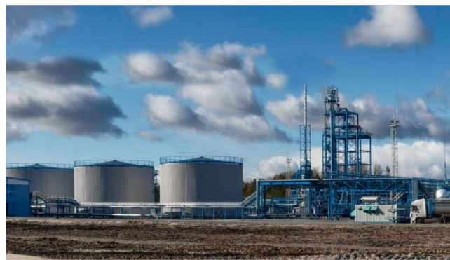
ФГУП «Завод им. Морозова», Ленинградская обл., п. Морозовка
